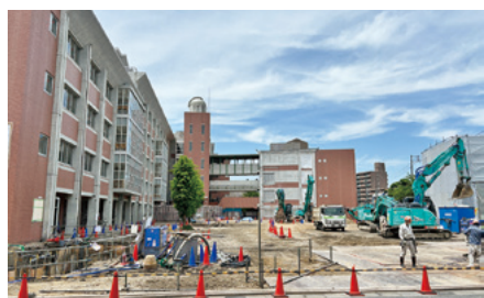
旧本館解体工事の様子
