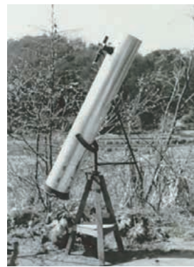
写真2 中学3年時自作の口径16cm 反射望遠鏡 昭和35年11月
